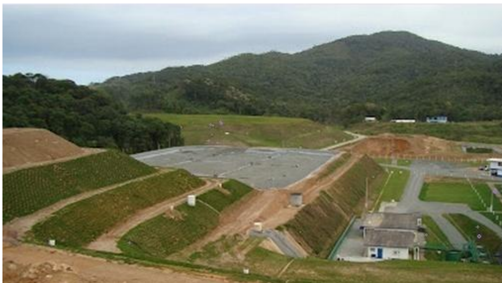
Figura 26- Aterro Sanitário de Itajaí – Canhanduba.
