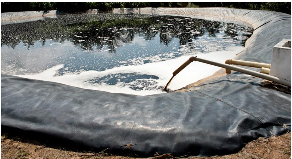
Foto 11. Aterro Sanitário de Brusque – Lagoa de chorume (2012)
