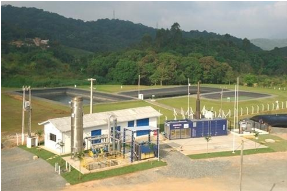
Figura 32 – Foto aérea da usina de energia do Aterro Sanitário de Canhaduba – Itajaí, SC Fonte: EmVideira (2014)
