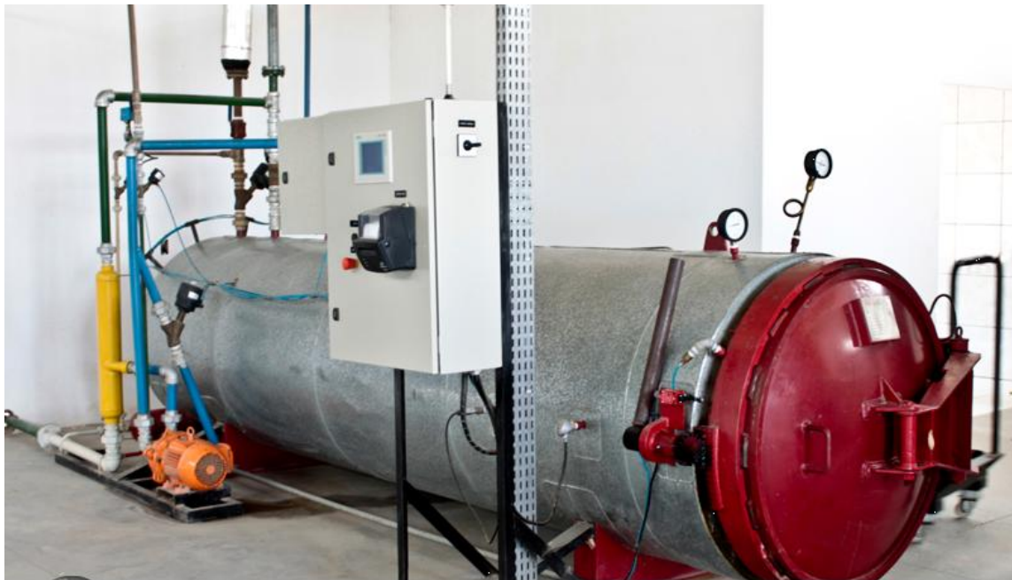
Foto 7. Autoclave onde os resíduos de saúde são esterilizados. Fonte Secundária: Blog Expedição Vida
