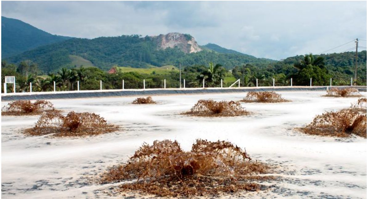
Foto 12. Aterro de Brusque – Lagoa de tratamento do Chorume (2012)
