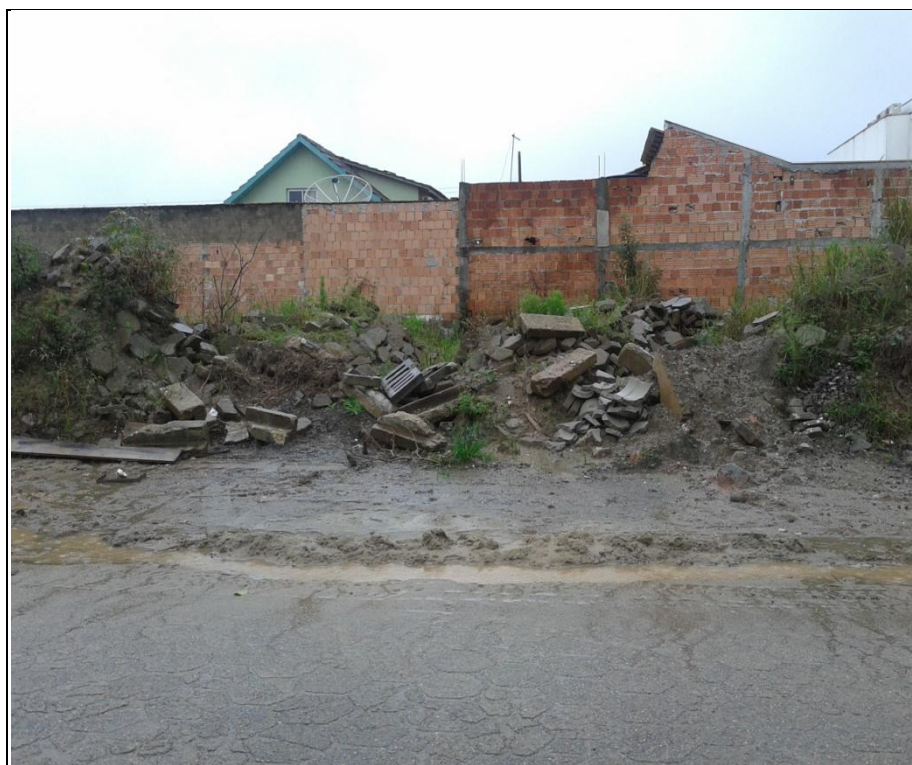
Figura 7 - Material proveniente de limpeza de terreno e acúmulo de RCC próximo ao pátio da secretaria de obras
