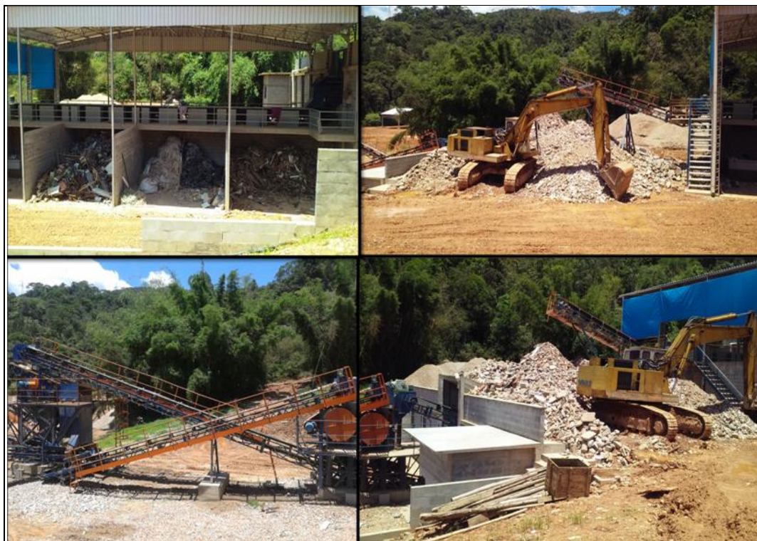
Figura 18 - Equipamentos utilizados na reciclagem de RCC
