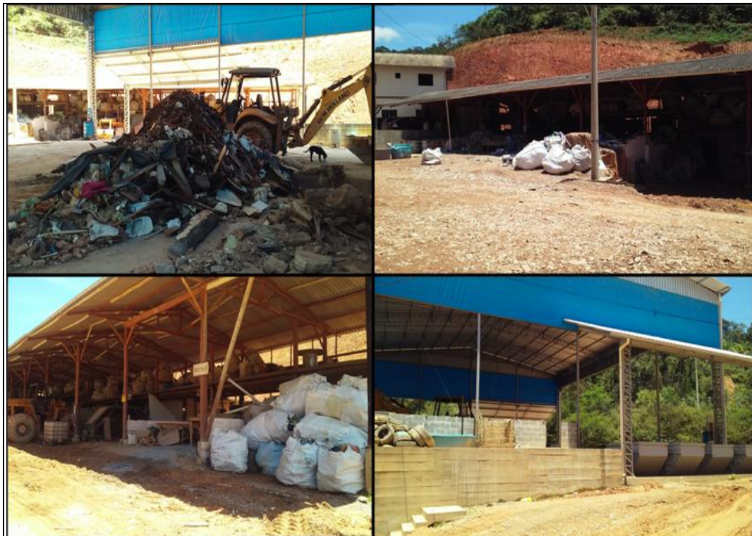
Figura 19 - Estrutura do local
