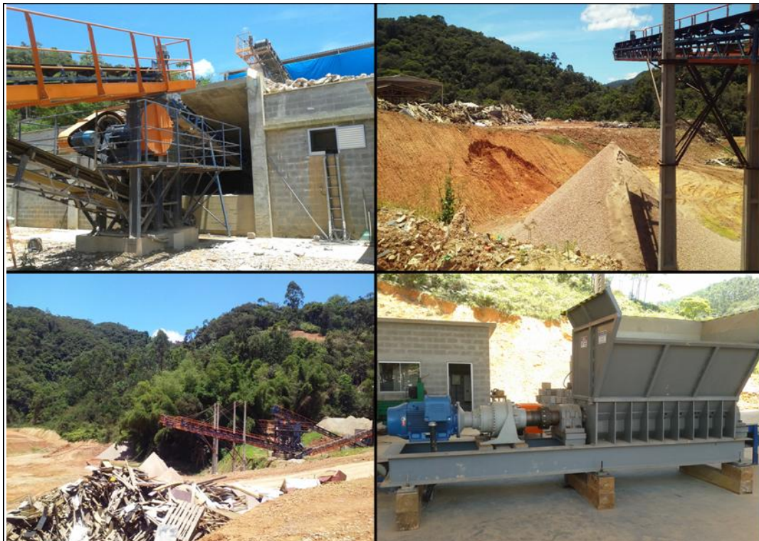
Figura 20 - Vista do local
