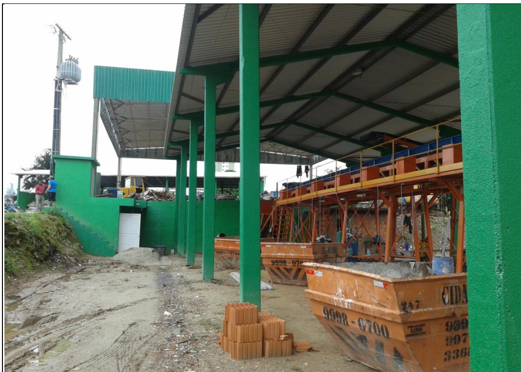
Figura 21 – Local onde serão separados os materiais triados do RCC
