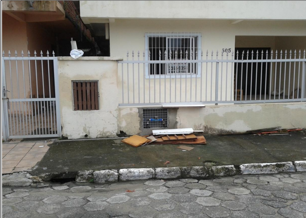
Figura 4 - Disposição de RCC em frente a calçada de forma irregular
