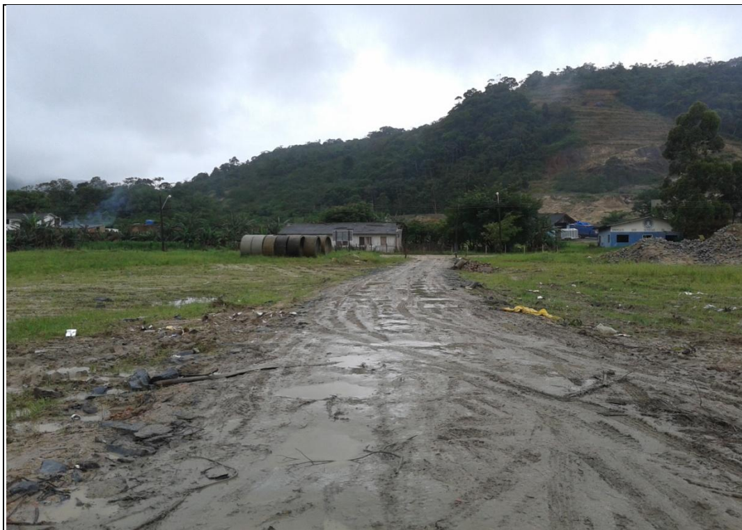
Figura 15 - Acesso interno do Centro de Triagem
