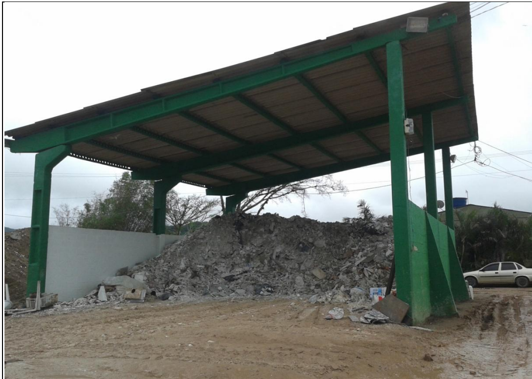
Figura 24 - Galpão fechado para recebimento de gesso
